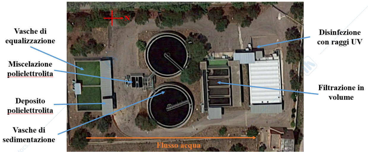
Affinamento depuratore di Gallipoli
