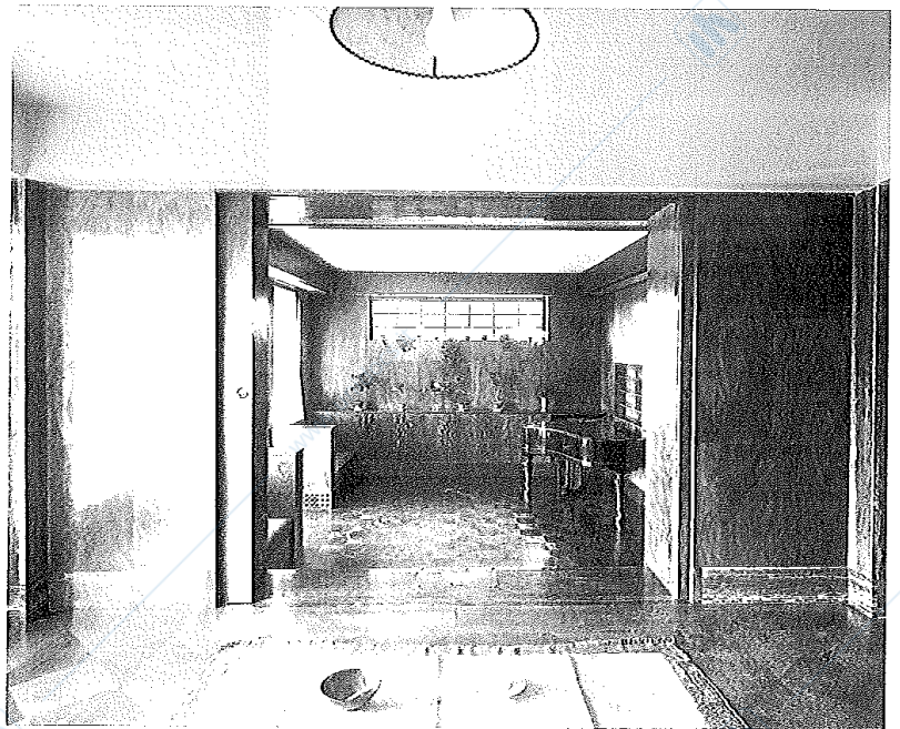
Foto d'archivio della situazione originale. Vista dalla stanza da pranzo verso la sala della musica. Forti influenze della cultura giapponese sono visibili nella progettazione degli interni di Loos per questa casa.
