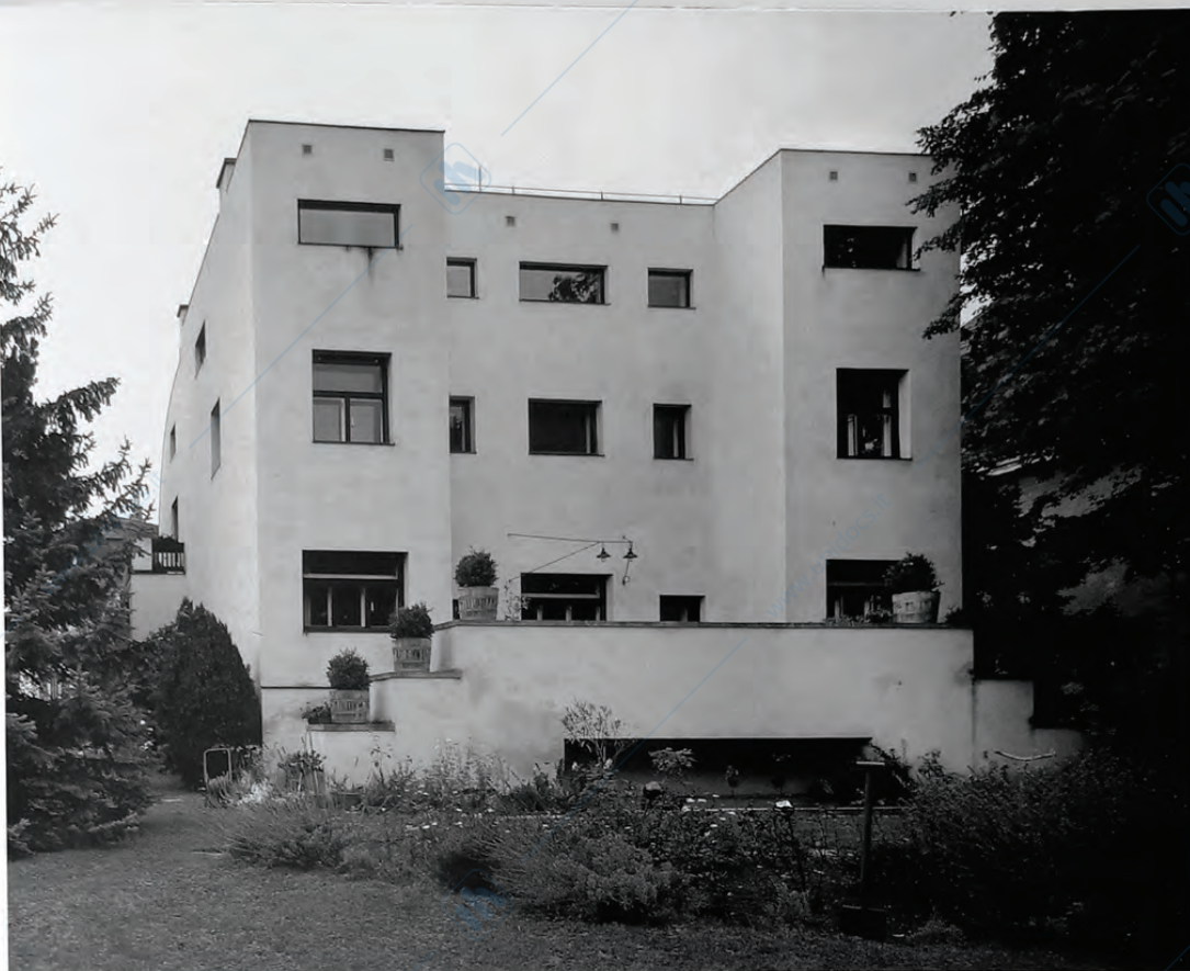
Vista attuale dal giardino, con facciata a tre piani. Vasca per l'acqua sotto il terrazzo. Accesso al terrazzo tramite una porticina sulla destra della finestra centrale. Accesso al giardino tramite scale laterali; balaustra in muro liscio verso il giardino
