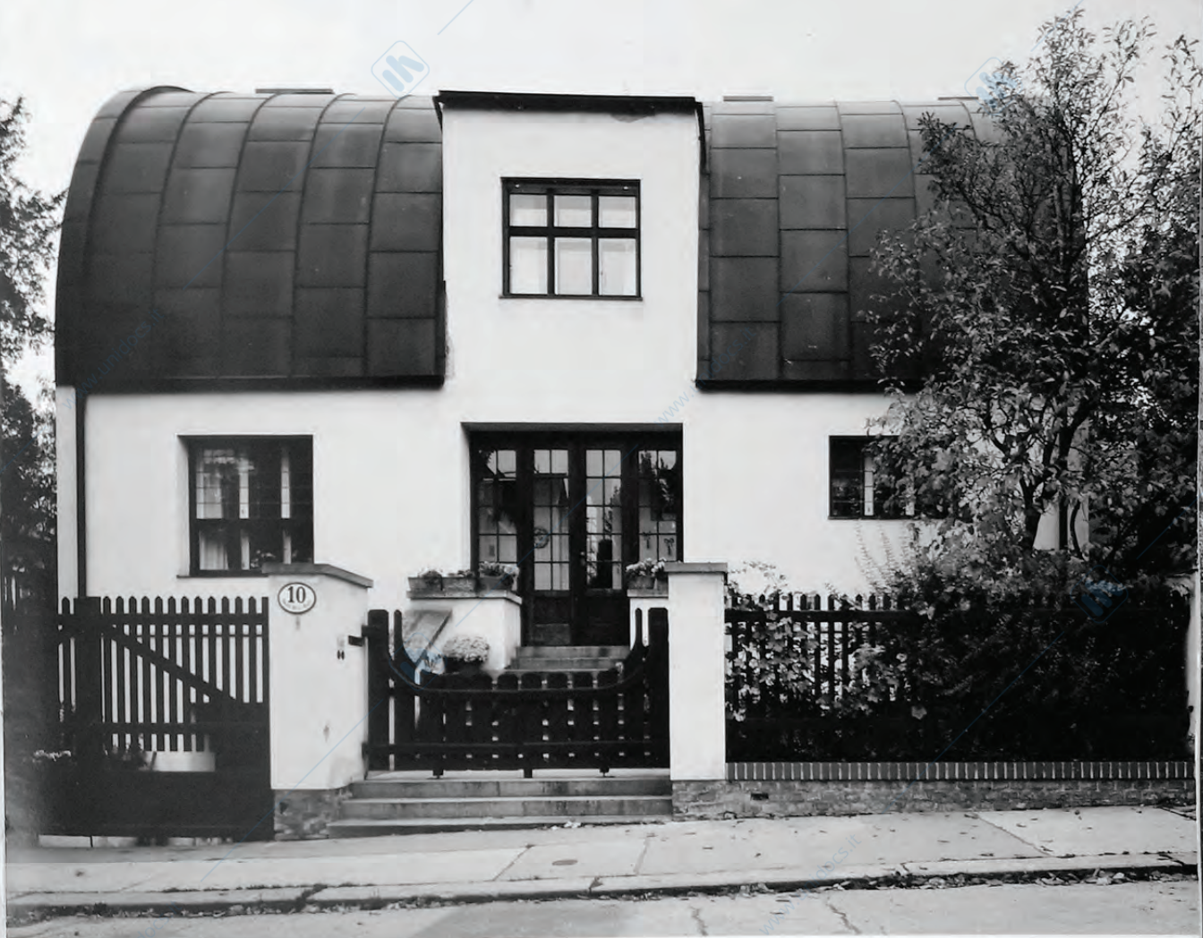
Vista attuale dalla strada, l'ingresso è stato modificato dalla famiglia Steiner, dall'idea originale di Loos con una nicchia (vedi piante)
