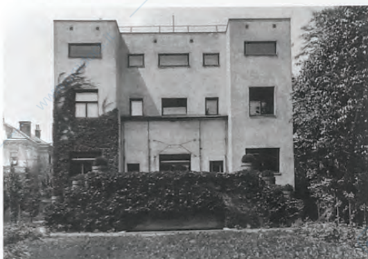
Vista della facciata originale sul giardino (ALA 3236)
