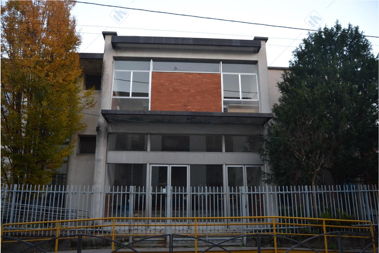
Facciata Ovest della parte di edificio ampliata nel 1962
