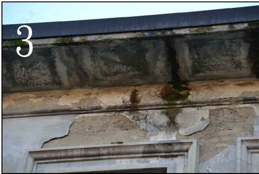
3 Anomalia: tenuta canale di gronda Scheda: 7
