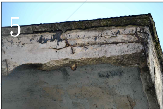
5 Anomalia: distacco membrana Scheda: 6
