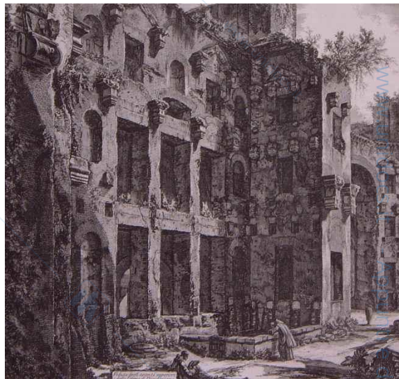
Terme di Diocleziano – colonne libere, altezza, ritmo, peso volte ricade sulla struttura a meandro.
