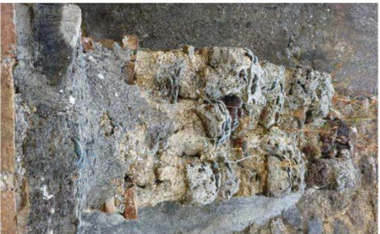
Figura 67. Opus caementicium con malta terrosa e materiali molto eterogenei (Pompei, VIII, 5, 24).
