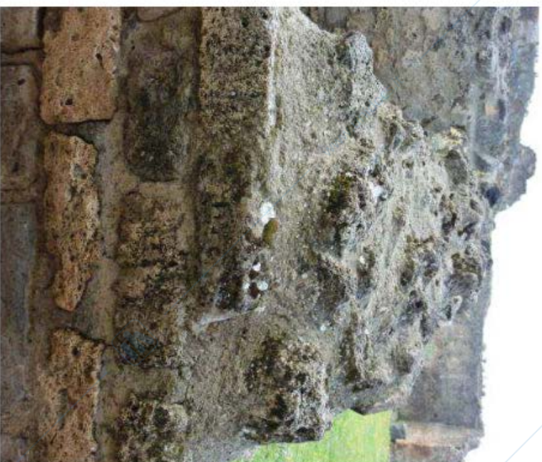
Figura 68. Opus caementicium con malta di buona qualità e ottima coesione fra gli elementi (Pompei, tempio dei Lari Pubblici)
